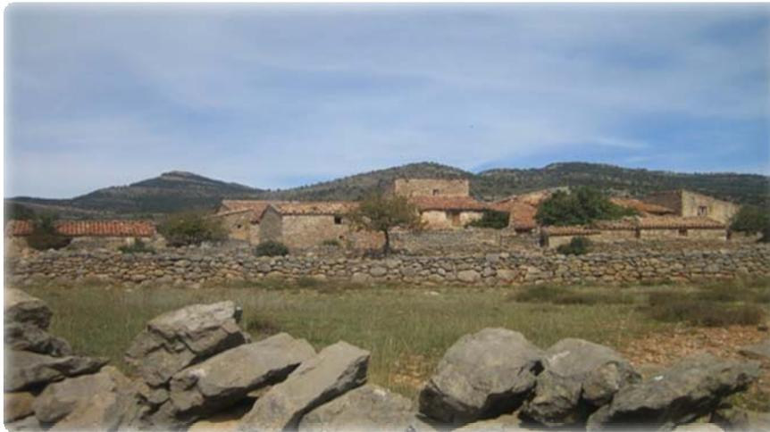
Además de la piedra en seco, las viviendas y demás estancias están compuestas por otros materiales de construcción como la madera, el cañizo y la teja utilizados en las cubiertas o diferentes tipos de mortero empleados en algunos tramos puntuales de las fachadas para reforzar las estructuras.
