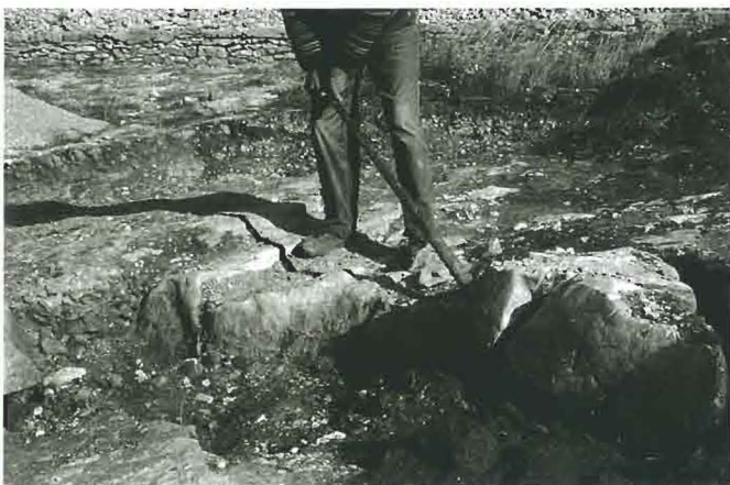
Clavant un tascó amb el martell per trencar un rotgla de pedra.
