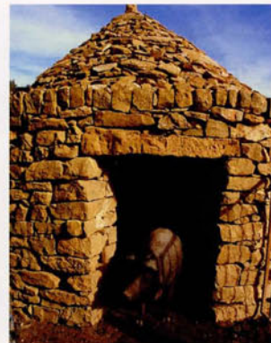
D'ESQUERRA A DRETA: Corral amb un espai cobert i tanca ortogonal. Tírig (Castelló).
